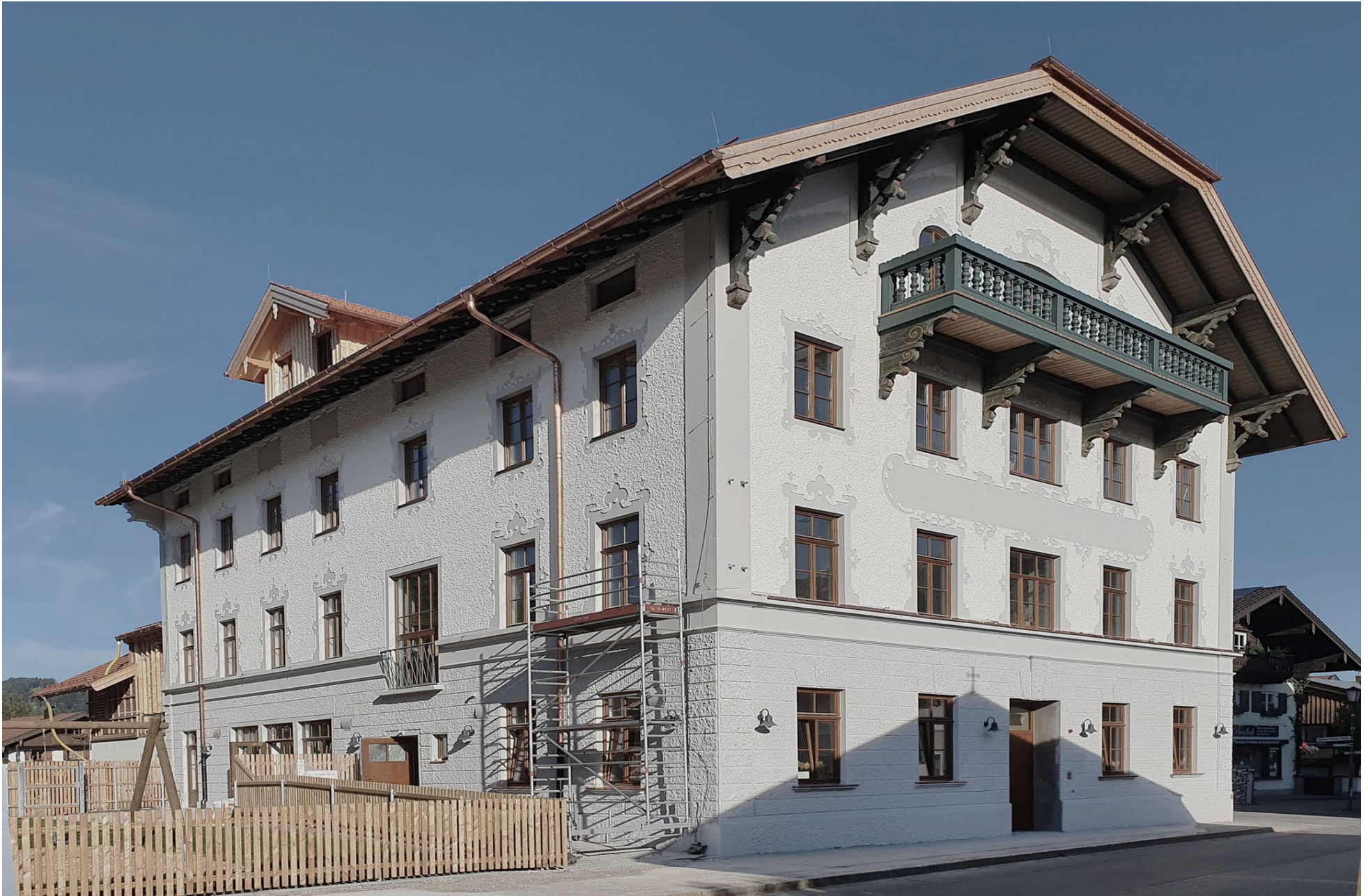
Nutzungsänderung und Sanierung „Gasthof Post“ in Lenggries, Architekten Händel Junghans
