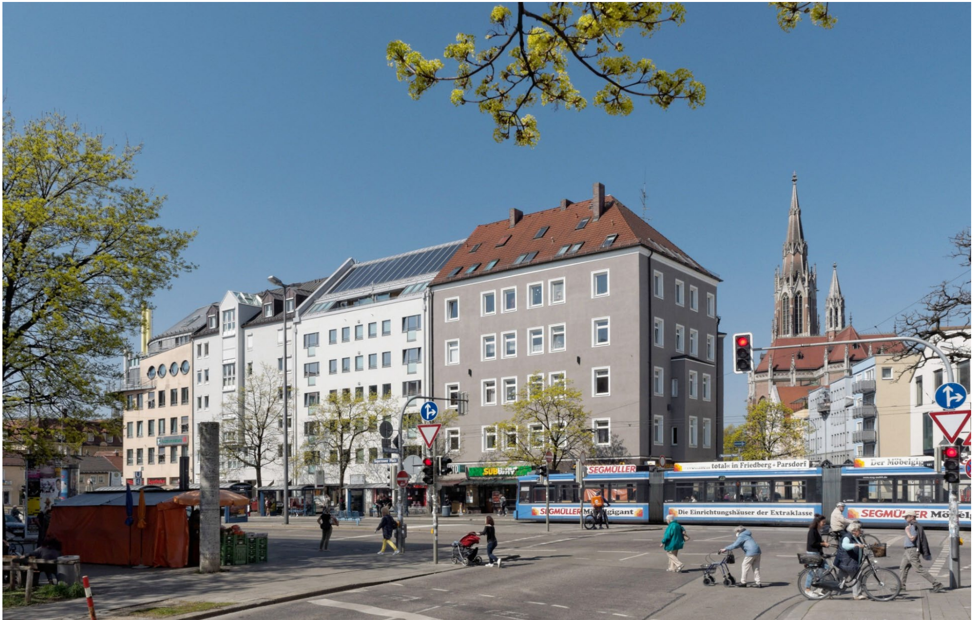
Sanierung in München, Architekt Florian Lichtblau
